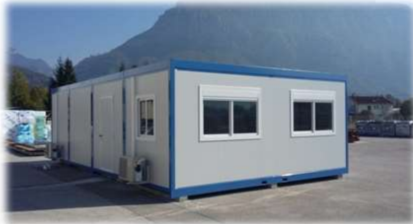
Exemple d'une base vie
