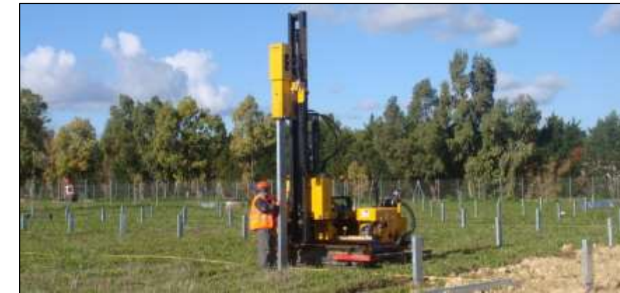
Figure 14. Sonnette de battage hydraulique
