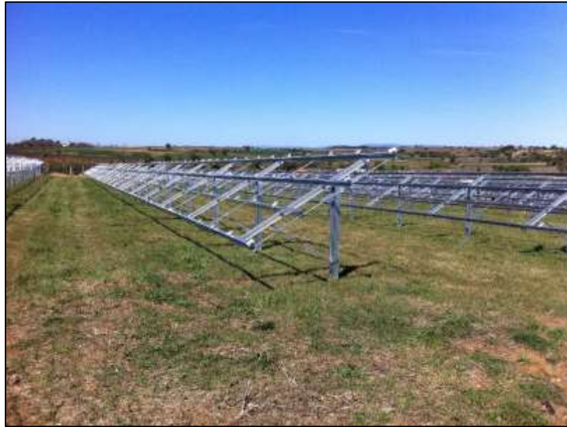
Photo 12 : Exemple de structures fixes
