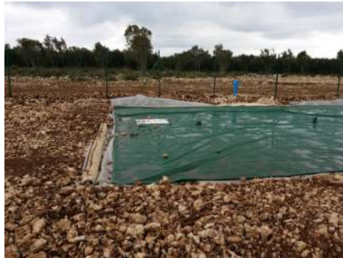
Illustration d'une citerne souple avant remplissage
