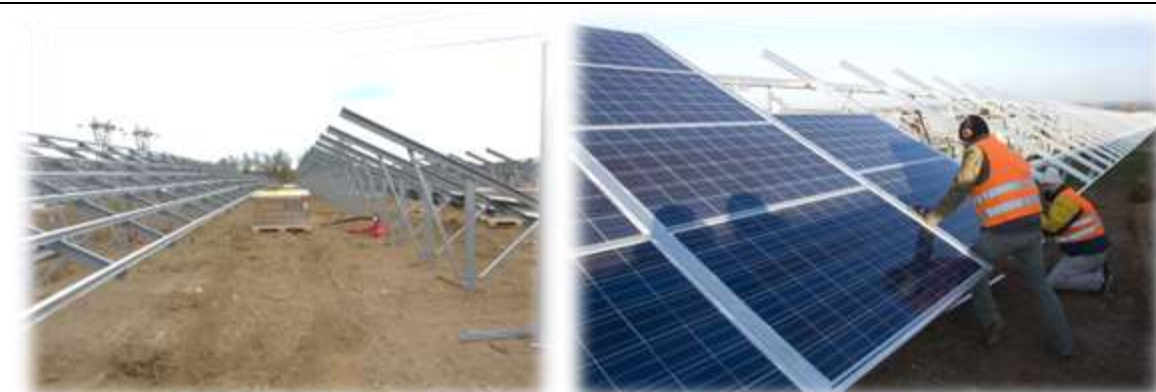
Montage des structures et pose des panneaux
