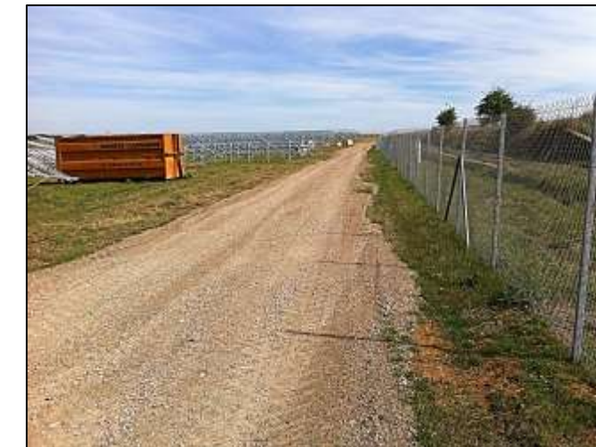
Exemple d'une bande de roulement adaptée aux véhicules lourds
