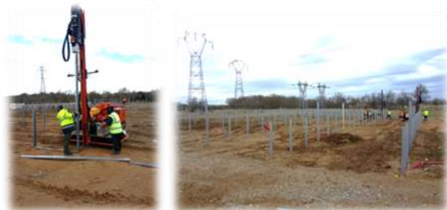
Mise en place des pieux battus
