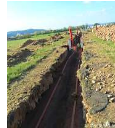
Photo 14 : Tranchée pour câblage
