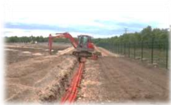
Enfouissement des réseaux
